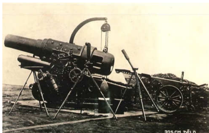
Těžké dělo ráže 30,5 cm neboli moždíř se vyrábělo ve Škodových závodech v Plzni. Střely do tohoto hmoždíře se odlévaly také v Janáčkově strojárně ve Starém Ransku.
