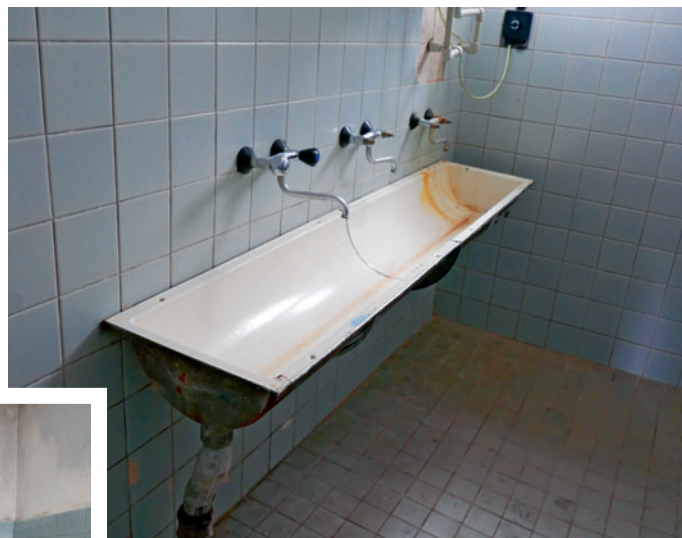
Umyvadlový žlab ve sprchách před rekonstrukcí
