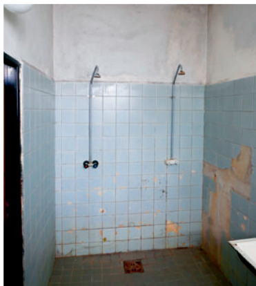
Sprchy před rekonstrukcí
