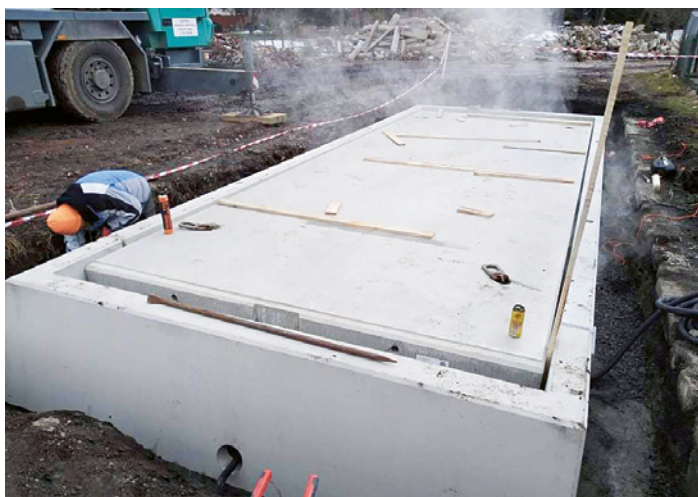
Nová váha na sběrném dvoře V dubnu byla na sběrném dvoře nainstalována mostní váha pro vážení automobilů.
