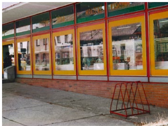
Původně byla severní stěna prodejny prosklena, vchod byl uprostřed stěny.
