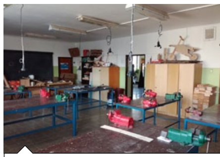
Učebna a dílna před rekonstrukcí
